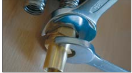
Festziehen der Klemmringverschraubung (ohne Dichtung festziehen)
