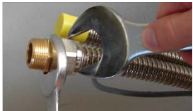
Anschluss- bzw. Doppelnippel aufsetzen und Verschraubung festziehen
