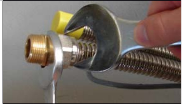
Herstellen der Dichtfläche
