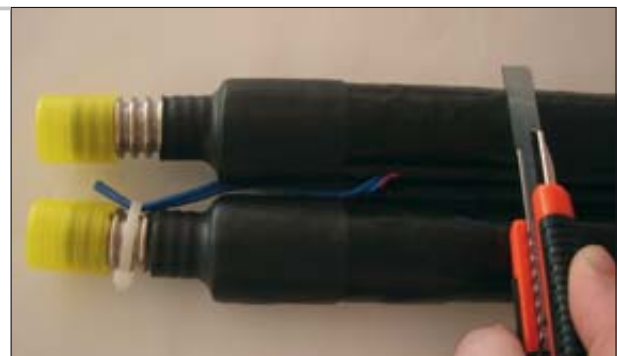
Abtrennen der Isolierung
