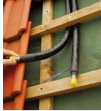
Auch in schwierigen Einbausituationen unter der Dachkonstruktion ist die Einbringung problemlos und einfach möglich.
