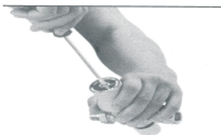
Der Druckminderer in der Füllarmatur ist bei Inbetriebsetzung der Anlage auf den Fülldruck des Membran-Ausdehnungsgefäßes einzustellen.
