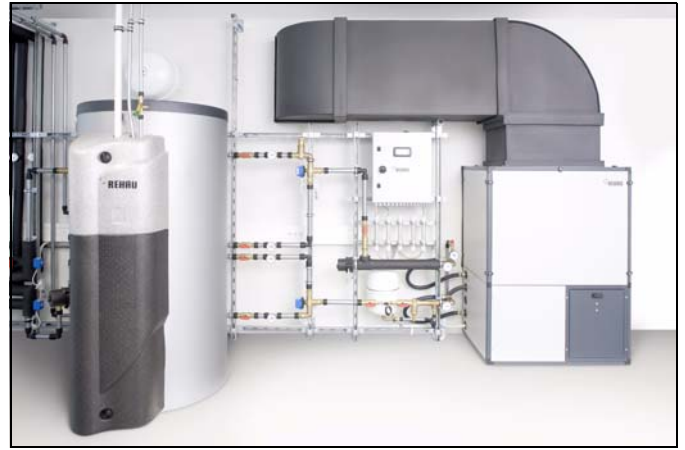
Abb. 7-4 Anschluss Wärmepumpe AERO
