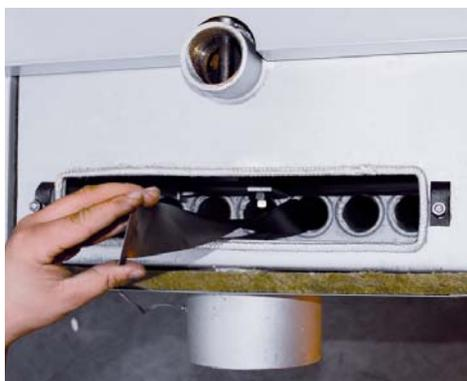
Die mitgelieferten Turbulatoren werden bei Bedarf, wie in der Abbildung ersichtlich, in die Abgaswärmetauscherrohre eingesetzt.
